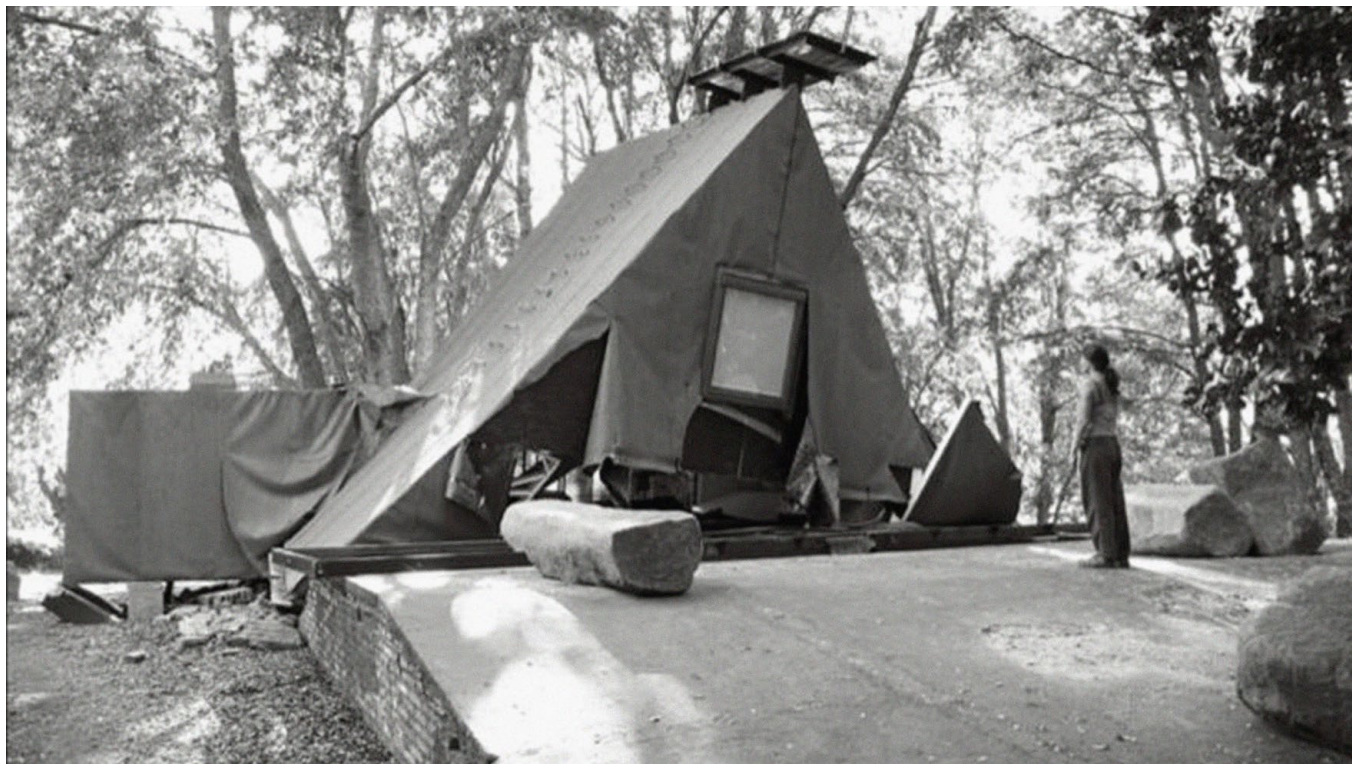
"Casa A" (2008) destruída após o terremoto de 2010. Fonte: A+U: Nenia Project, n.611, 2021, p.8.
