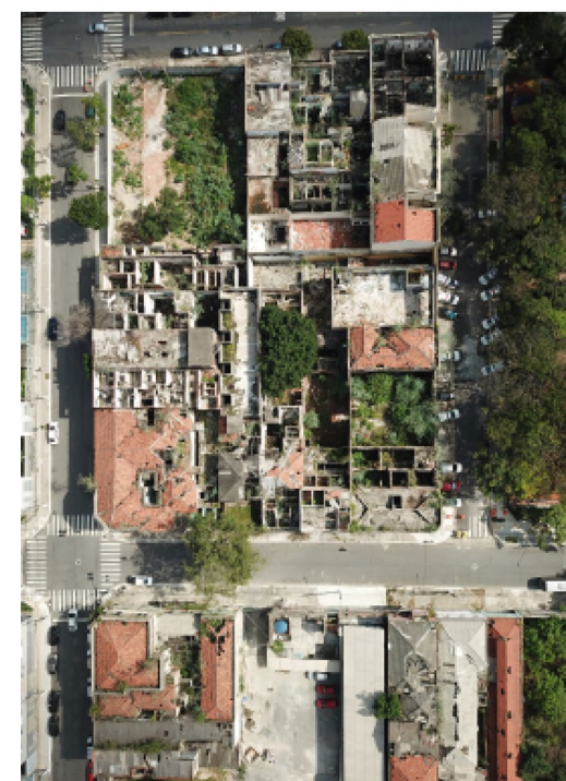
FIG. 17: Página do Caderno de Campo do G01. Foto aérea do estado atual das quadras 37 e 38. Fonte: Gabriel Wissenbach, estudante, em abril de 2025.
