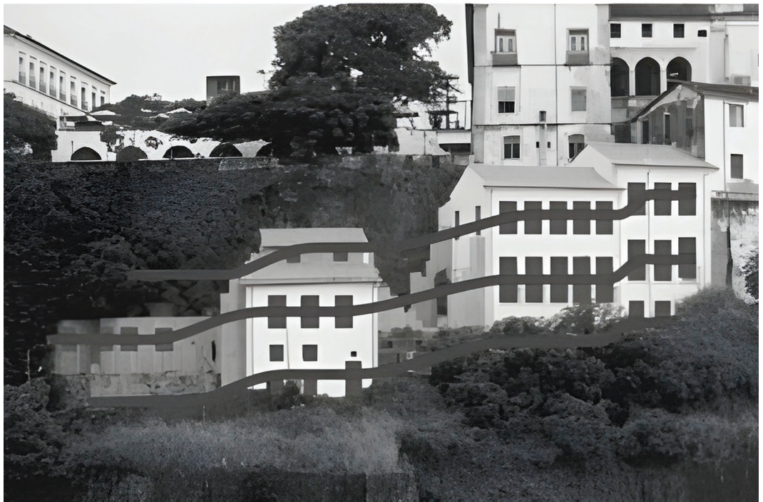
FIG. 5: Vista da Ladeira da Misericórdia em que podemos perceber a continuidade dos níveis das janelas, ao mesmo tempo que seguem a declividade da ladeira.
