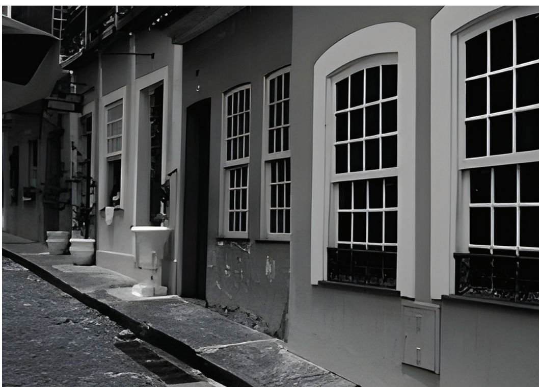
FIG. 4: Janelas típicas das edificações históricas de Salvador. Fonte: O QUE FAZER..., 2021.
