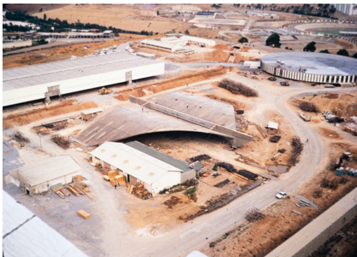
FIG. 3: Auditório da Universidade de Constantine em construção. Fonte: Fotografia em slide cedida por Cecília Saliture, 1970-1975.
