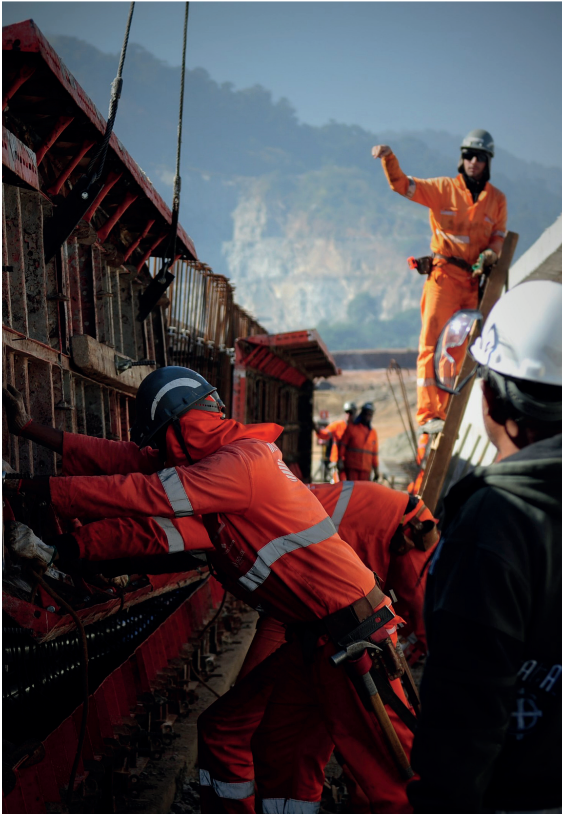
Rodoanel, Trecho Norte, Guarulhos. Fonte: foto da autora, 2016
