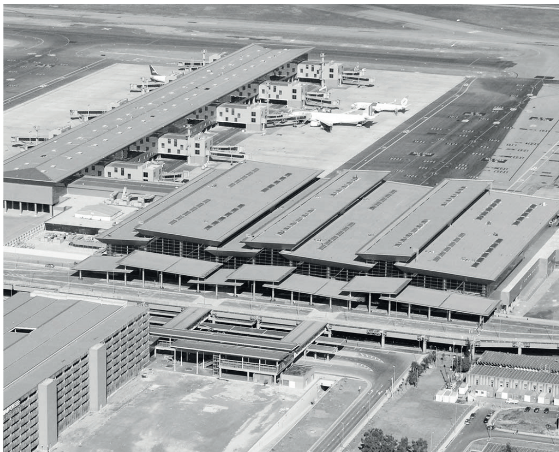
Figura 4. Foto aérea do Terminal 3 após a conclusão da obra. Fonte: GELINSKI, 2016.
