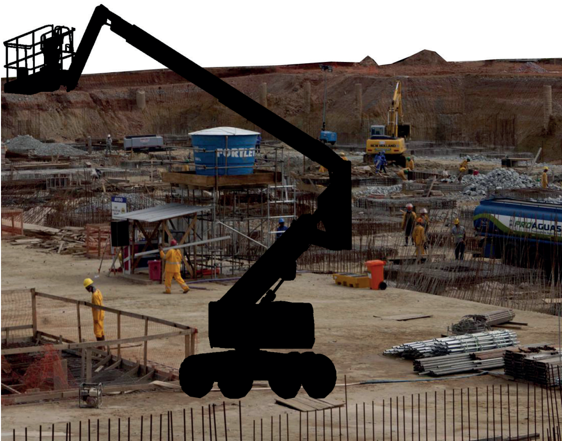
Canteiro de Obra. Fonte: montagem da autora, 2017
