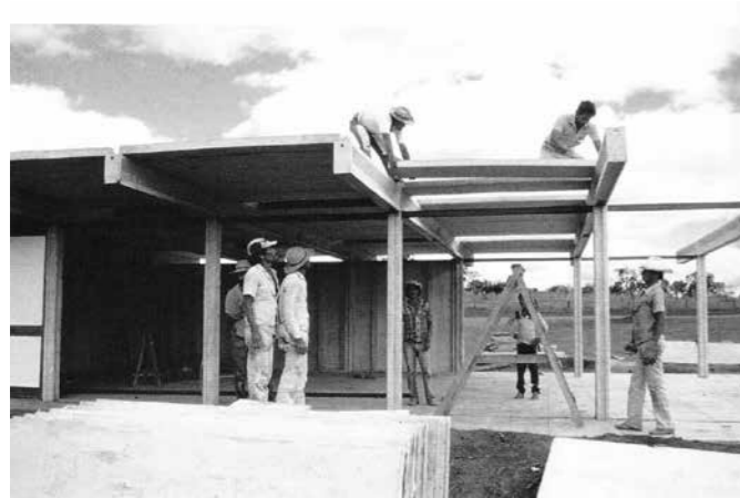
Figura 3. Trabalhadores montam cobertura com painéis de argamassa armada para escola-modelo de Abadiania. Fonte: LATORRACA, 2000.
