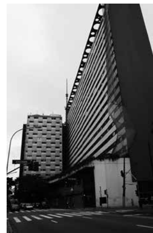
Figura 5. Edifício Nações Unidas. Vista da Avenida Brigadeiro Luiz Antonio (sentido centro). Fonte: fotografia da autora, 2010.
