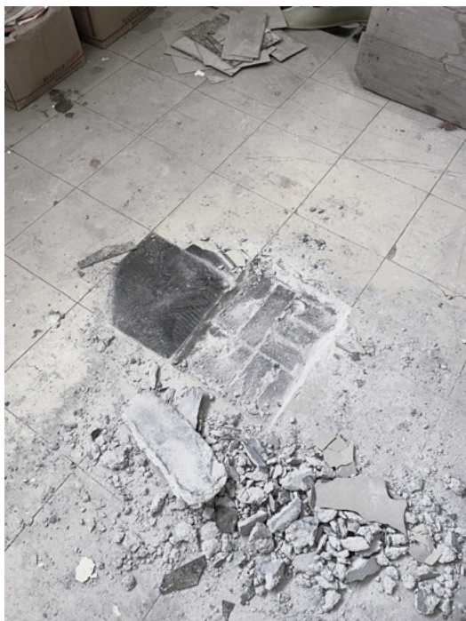
FIG.5: Fragmento do piso original da sala sob vinílico recente, exposto a partir de escavação arqueológica. Fonte: Registro da autora, ago. 2023.
