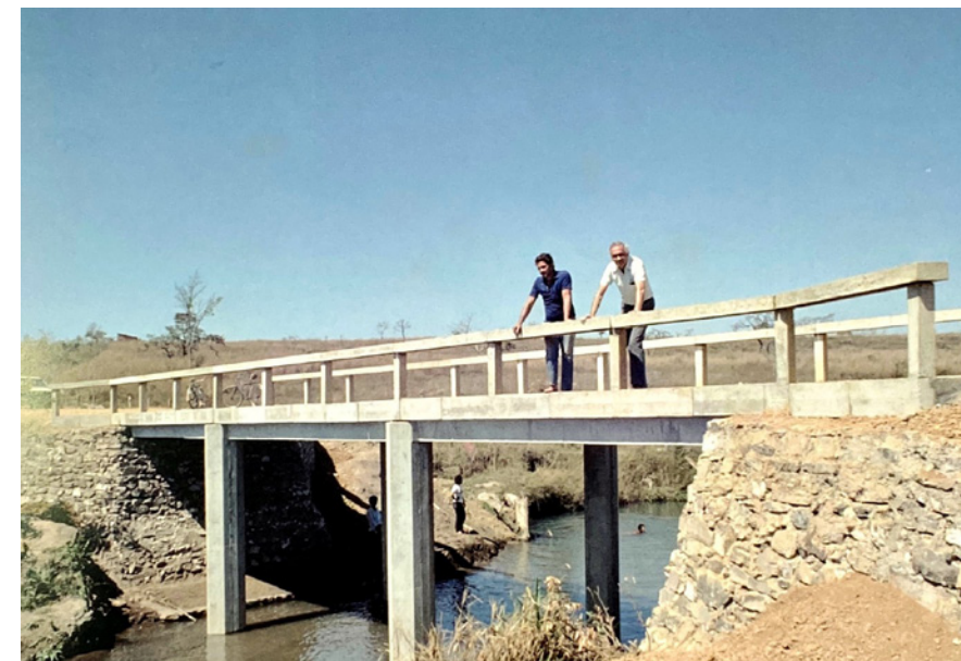
FIG. 4: Pontilhão em Abadiânia, Goiás. Fonte: Lago et al., 2010, p.41.
